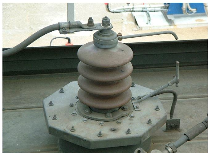
Ces éclateurs n'ont pratiquement aucun pouvoir de coupure. Ils sont destinés en **dernier ressort** à écrêter les surtensions dans le cas où les autres systèmes n'auraient pas fonctionné.
