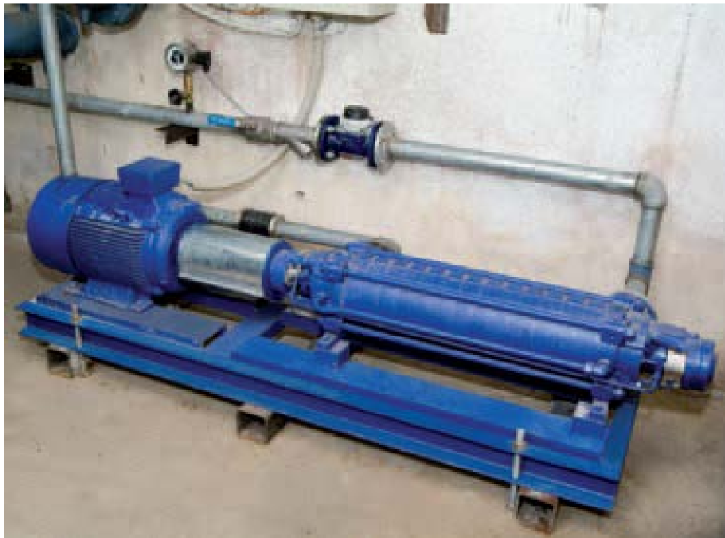
Pompe multicellulaire horizontale sur châssis, support avec manchon d'accouplement
