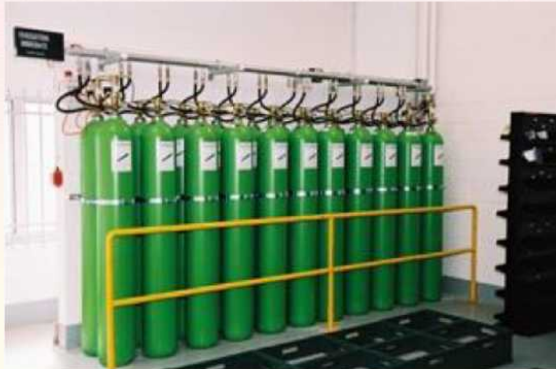
Système d'extinction automatique par gaz inerte Argon 55
