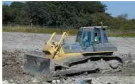
Véhicules de chantier
