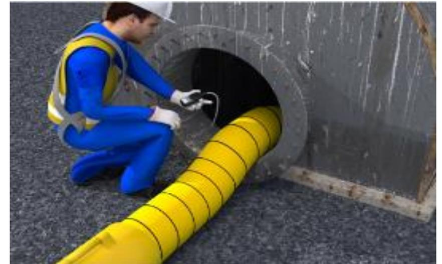
Détection des gaz : Oxygène entre 19,5 % et 23 %
