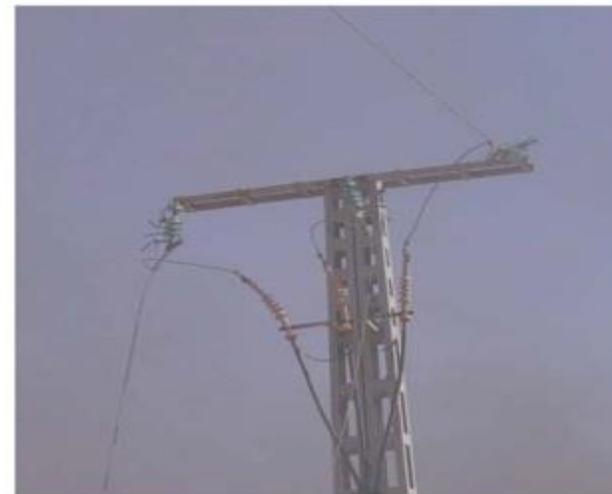
Amorçage entre ligne haute tension et PEMP
